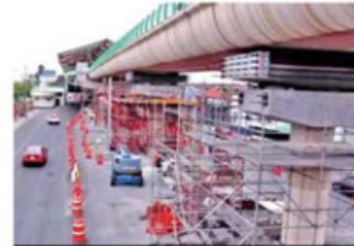
Trabajadores de Metrorrey redoblarán las acciones de reparación de capiteles del viaducto elevado de la Línea 2
